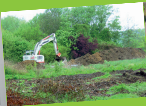
2008_NEUBAU-02: 2008: DAS GELÄNDE AM EULERSWEG ZU BEGINN DER BAUARBEITEN
